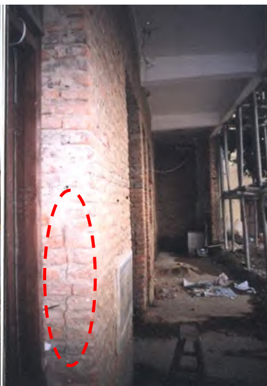
某砖混结构底层墙体出现竖向裂缝，该建筑在不久后倒塌
