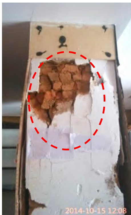
某砖混结构底层墙体出现竖向裂缝，该建筑在不久后倒塌
